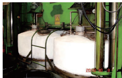
硫化机施工后
