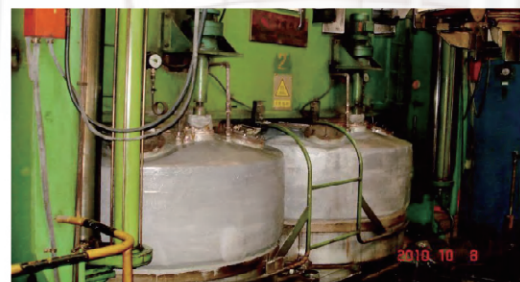
硫化机施工前
